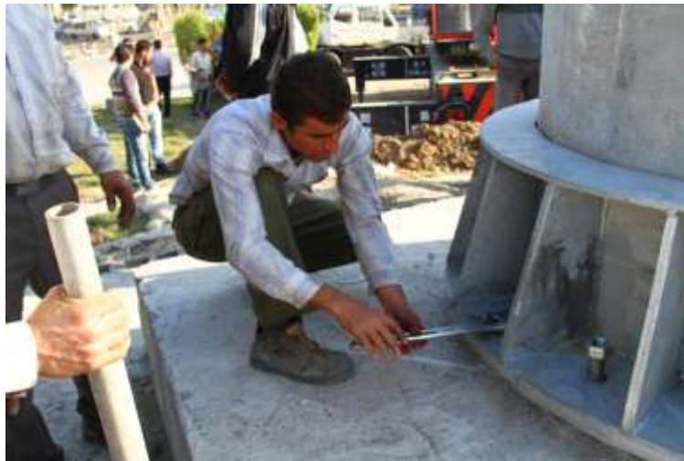
استقرار میل پرچم بر روی فونداسیون و سفت کردن مهره ها
