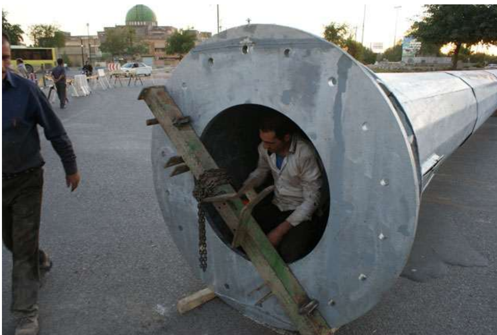
جک زدن و مونتاژ بخش تحتانی میل پرچم
