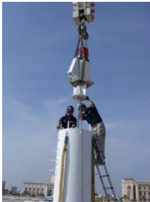
نصب چراغ هشدار بر فراز میل پرچم، جهت جلوگیری از برخورد هواگرد به میل پرچم در طول شب
